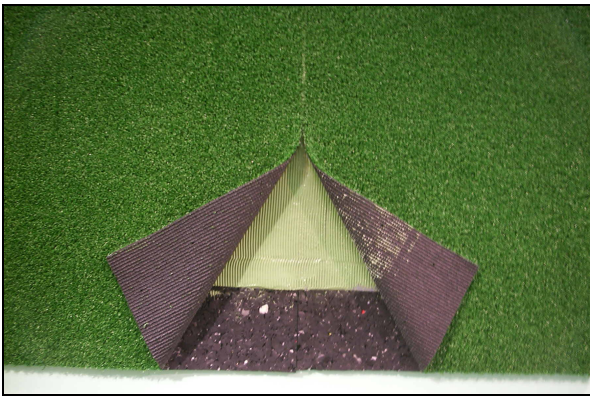
Particolare della giunzione
