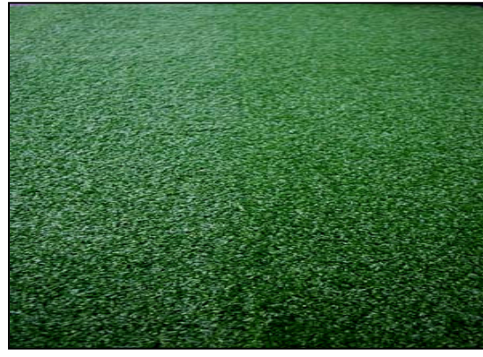
Ecco come appare la giunzione completata
