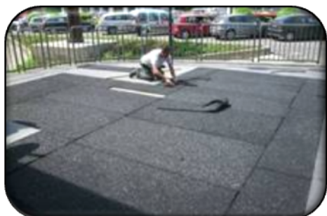
1 stesura del sottofondo in lastre da m. 2 x 1
