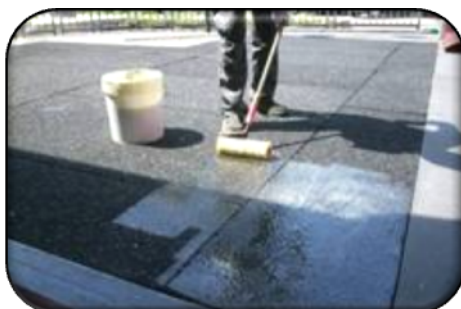
2 applicazione del collante monocomponente
