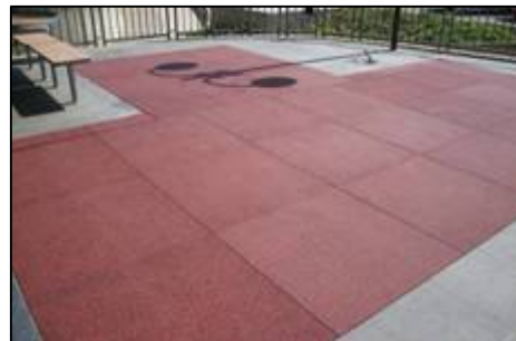
3 ricopertura finale con le piastrelle da cm.98x98
