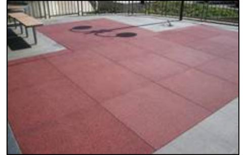
3 ricopertura finale con le piastrelle da cm.98x98
